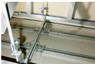
WBBカチットワイヤー16施工後
